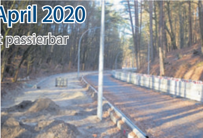
Die für Fußgänger, Radfahrer und Autofahrer neu angelegten Spuren sind weit fortgeschritten Foto: mk
