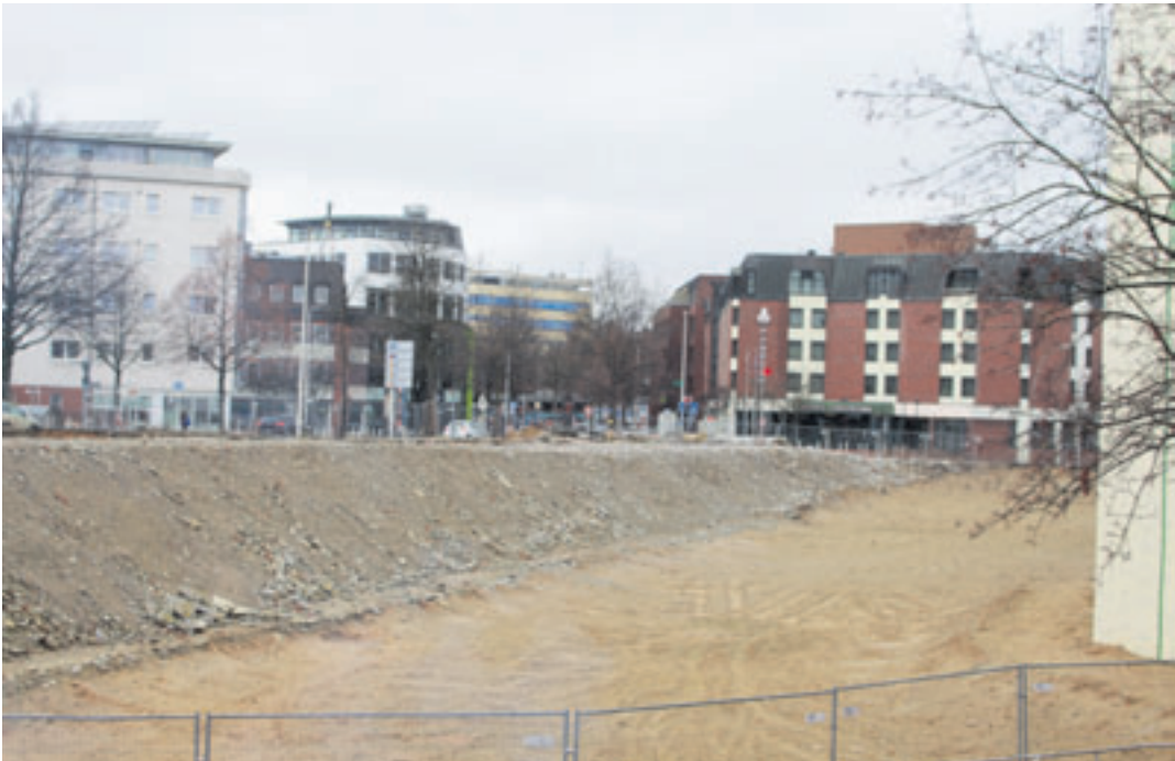
Die Baugrube am Harburger Ring: Das Spiel wiederholt sich. Erst konnte das Harburg-Center nicht abgerissen werden, jetzt wird der Neubau nicht in Angriff genommen. Foto: pm
