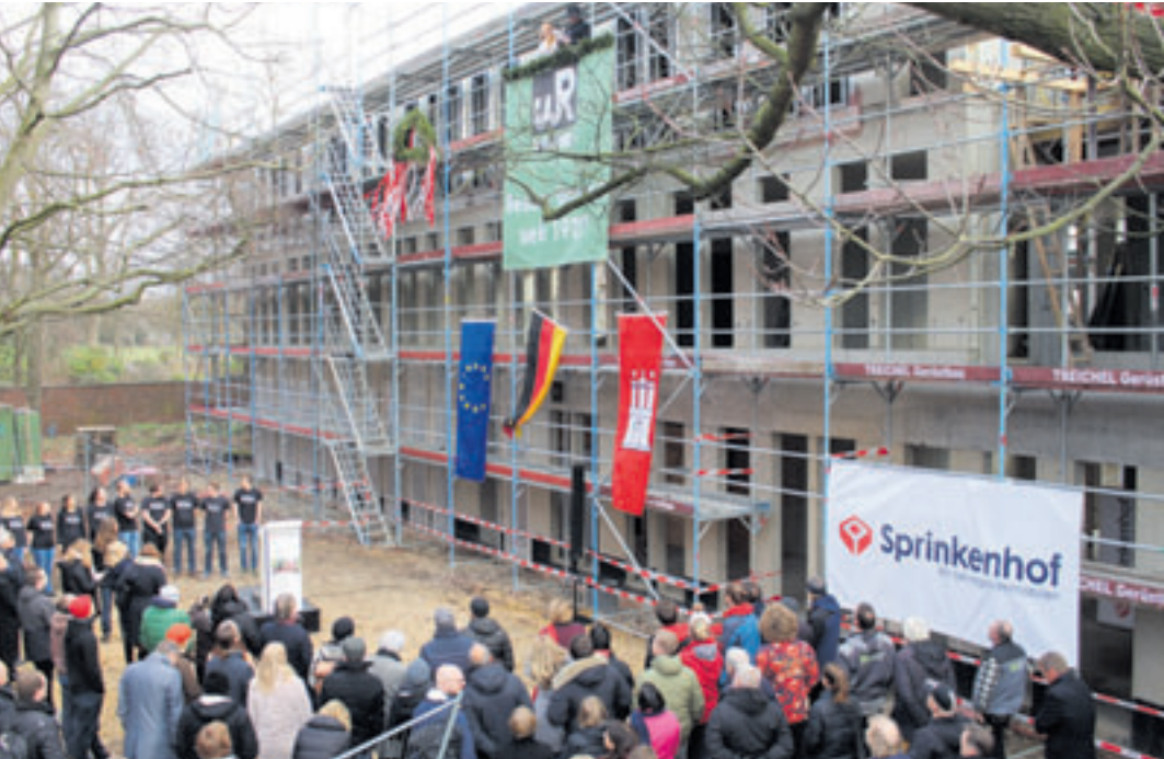
Der Richtkranz schwebt über dem Rohbau am Schwarzenberg
