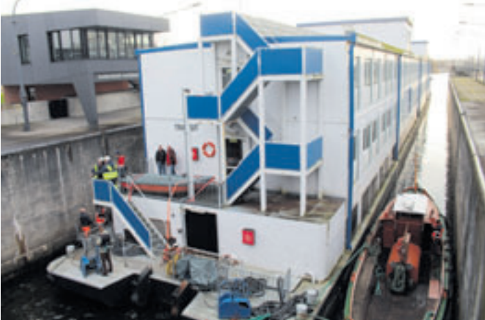
In der Harburger Hafenschleuse wurde es eng
