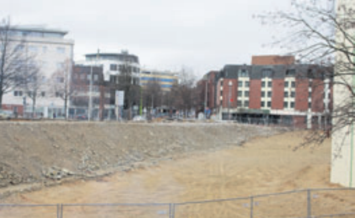
Früher Harburg-Center, jetzt vorübergehend Parkfläche? Foto: pm
