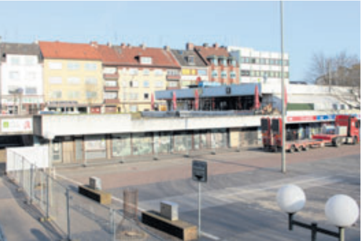
Der Sand mit dem ehemaligen „Bolero“ (re.), das demnächst abgerissen werden soll Foto: pm
