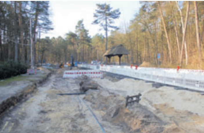
Auf Höhe der Rudolf-Steiner-Schule sind die Bauarbeiten in vollem Gang
