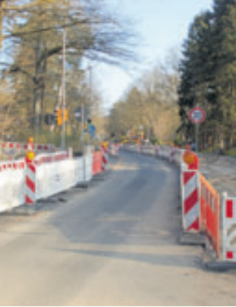
Durch diese schmale Gasse wird der Verkehr an der Baustelle vorbeigeführt
