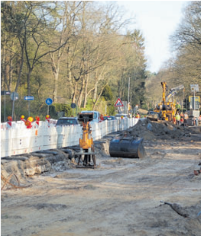
Der Ehedorfer Heuweg soll laut LSBG Mitte Juli für rund eine Woche wegen Asphaltierungsarbeiten für den Verkehr auf Höhe der Rudolf-Steiner-Schule voll gesperrt werden Foto: mk
