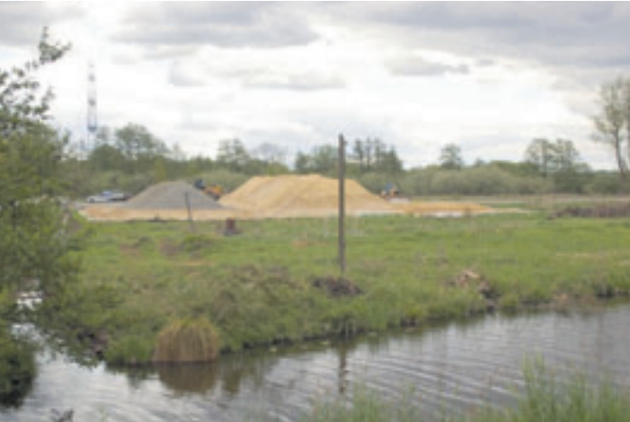
Idylle und Baustelle: Auch in der Nähe der Moorwettern laufen die Vorbereitungen für den Bau der A26 Foto: mk
