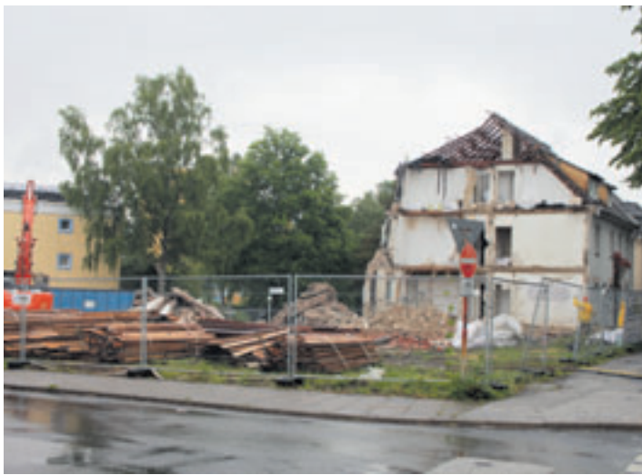
Der Abrissbagger in der Bremer Straße verrichtet ganze Arbeit Foto: priv.
