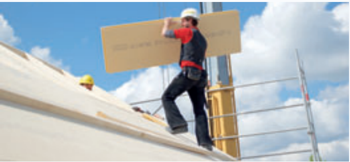
Experten-Tipp für die Modernisierung: Erst das Dach, dann die Wand dämmen. Foto: steico.com/akz-o
