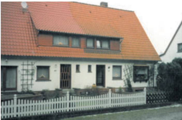
Dieses Siedlungsdoppelhaus in Maschen diente als Vorbild für die Rekonstruktion am Kiekeberg
