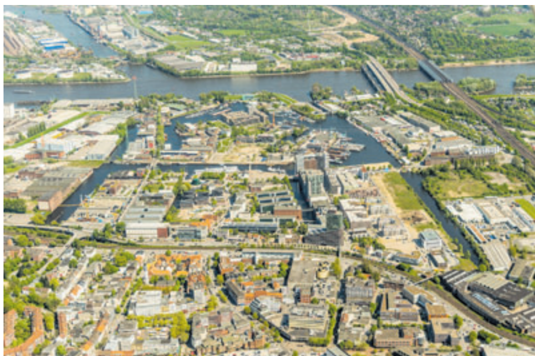
Auf der Schlossinsel im Herzen des Binnenhafens ist der Ursprungsort Harburgs noch zu erkennen. Hier begann um 1000 die Entwicklung Harburgs. Copyright: Stadtmuseum Harburg
