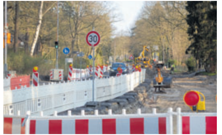
Die für die Sommerferien angekündigte Vollsperrung des Ehestorfer Heuwegs wird nicht erfolgen Foto: mk
