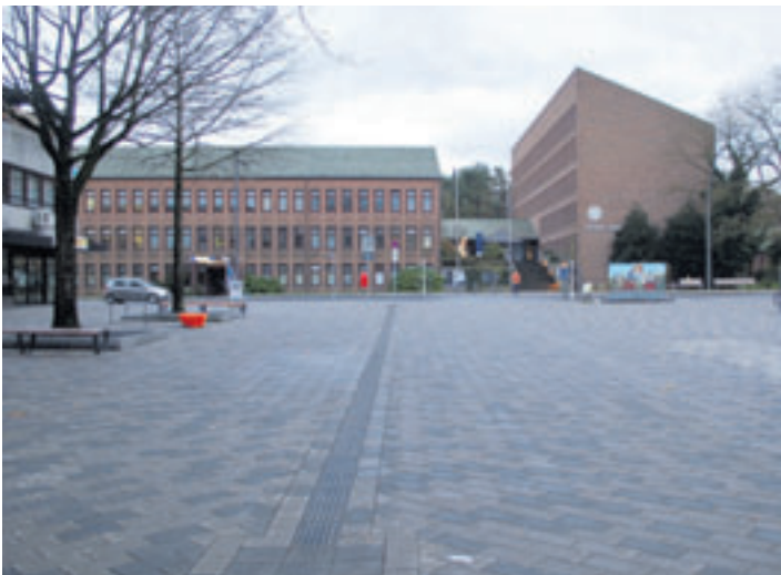
Das frühere Ortsamt Süderelbe wird vom Amt für Denkmalschutz als denkmalwürdig eingestuft. Foto: mk
