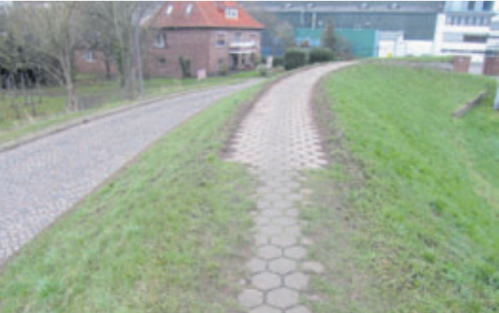
HPA hat in den vergangenen Wochen mit der Instandsetzung des Deichkronenweges auf dem Neuenfelder Estedeich begonnen Foto: HPA
