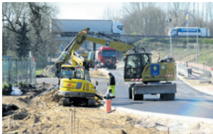
Bis zuletzt wurde mit Hochdruck an der Fertigstellung gearbeitet
