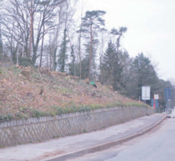
Als vorbereitende Maßnahme für den zweiten Bauabschnitt wurden zahlreiche Bäume in der Nähe des Schanzengrundes gefällt Foto: mk
