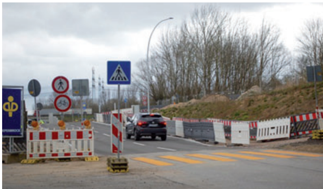
So sah es bei Redaktionsschluss am Donnerstag im Einmündungsbereich Waltershofer Straße aus. Mittlerweile erinnert kaum noch etwas an die monatelange Baustelle Fotos: W. Marsand
