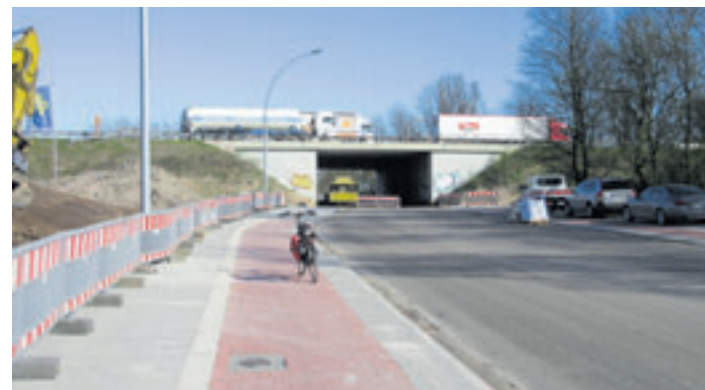
Im Zuge des Ausbaus für den Straßenverkehr hat die HPA auf beiden Seiten des Moorburger Elbdeichs auch einen neuen Geh- und Radweg fertiggestellt
