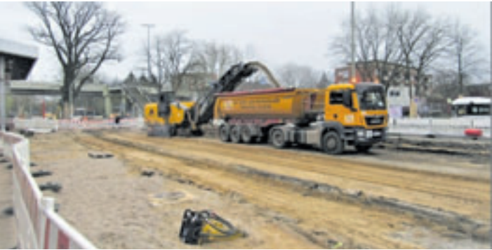
Wegen der Umbaumaßnahmen des Neugrabener S-Bahnhofes halten die Busse der Linie 140 aktuell nur im Vogelkamp Foto: W. Marsand
