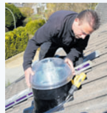
Dachdeckermeister Christian Wiese beim Einbau einer Solatube.
