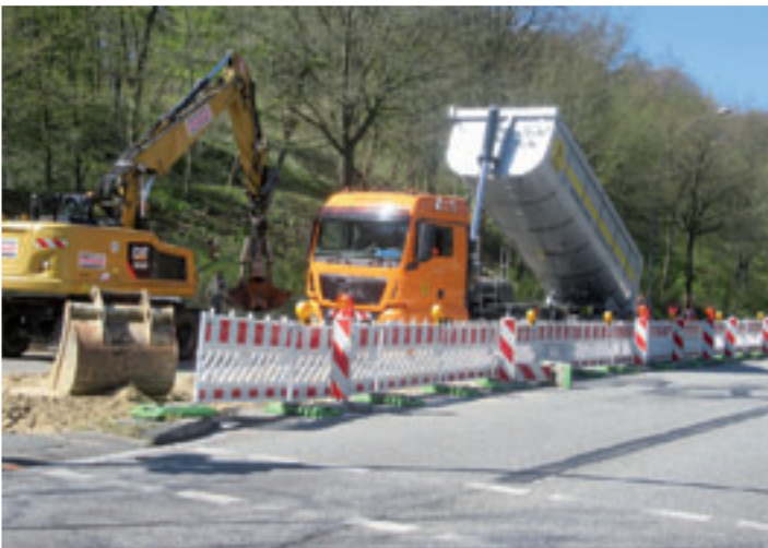
Bereits jetzt sind die Baurbeiten auf der Cuxhavener Straße in vollem Gange Fotos: W. Marsand
