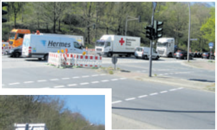
Vom 27. April bis 19. Juli ist die Waltershofer Straße zwischen Cuxhavener Straße und Zum Dubben wegen Straßenbauarbeiten für den motorisierten Verkehr voll gesperrt
