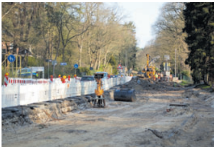
Der Ehestorfer Heuweg soll laut LSBG Mitte Juli für rund eine Woche wegen Asphaltierungsarbeiten für den Verkehr auf Höhe der Rudolf-Steiner-Schule voll gesperrt werden Foto: mk
