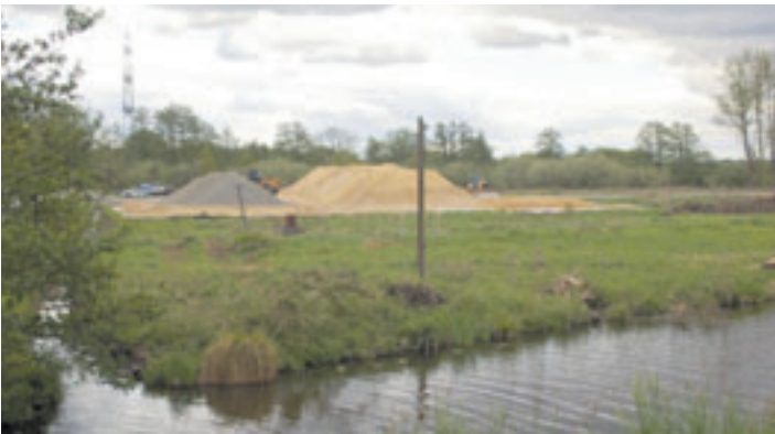
Idylle und Baustelle: Auch in der Nähe der Moorwettern laufen die Vorbereitungen für den Bau der A26 Foto: mk
