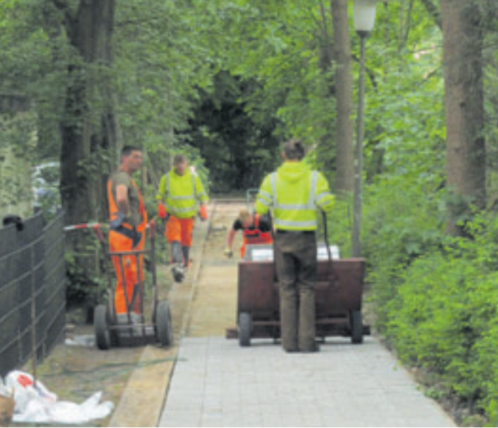
Arbeiter einer Baufirma erneuerten die Pflasterung des Durchganges Foto: W. Marsand
