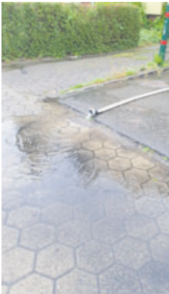
Mittels eines Schlauchs wurden das eingedrungene Wasser auf die Straße abgeleitet. Foto: hbo
