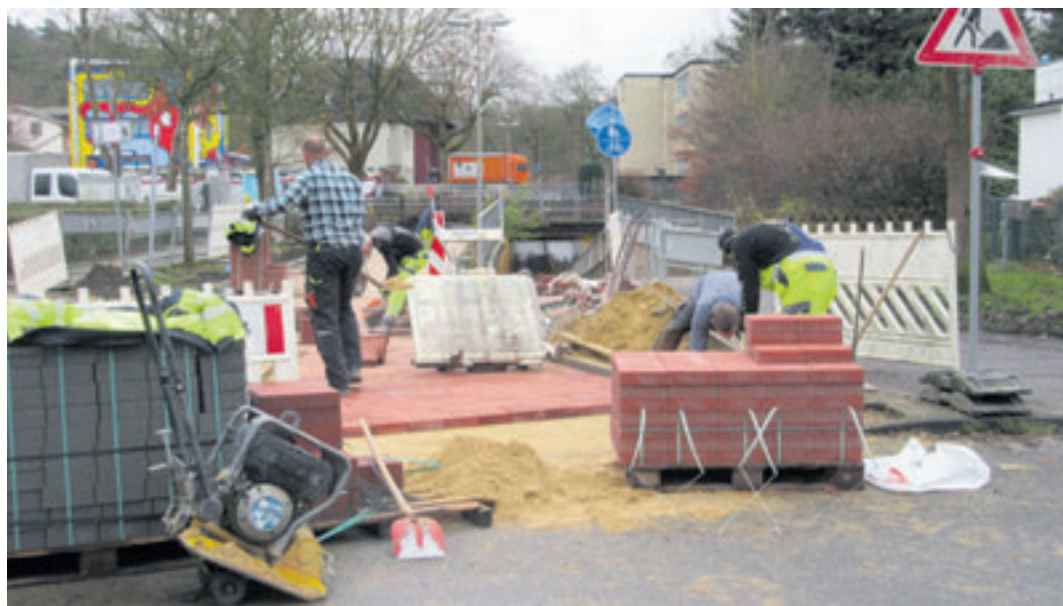
Im Winter 2019 begannen die Bauarbeiten zur Veloroute 10
