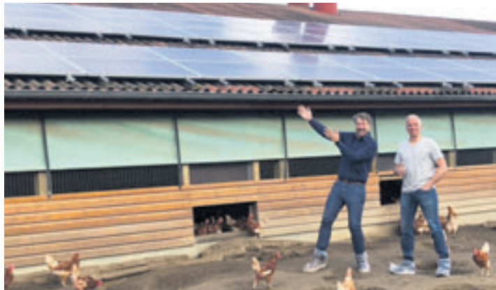
Henner Schönecke (l.) und Robert Neumann zeigen die Photovoltaik-Paneele Foto: Schönecke
