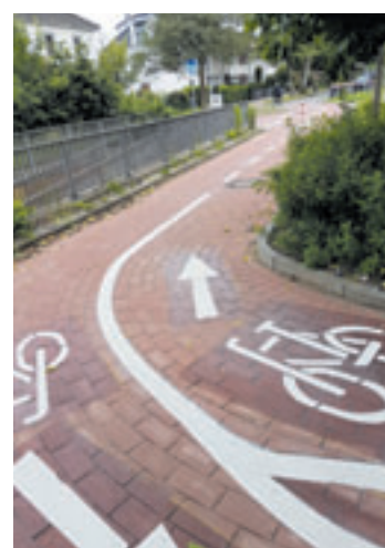
Durch den neuen, drei Meter breiten Zweirichtungsradweg wurde eine Verbindung zwischen dem Tempoweg und der Altwiedenthaler Twiete geschaffen
