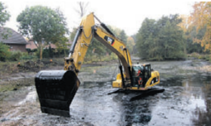
2012 schaufelte ein Bagger Schlamm aus dem Teich Fotos: W. Marsand
