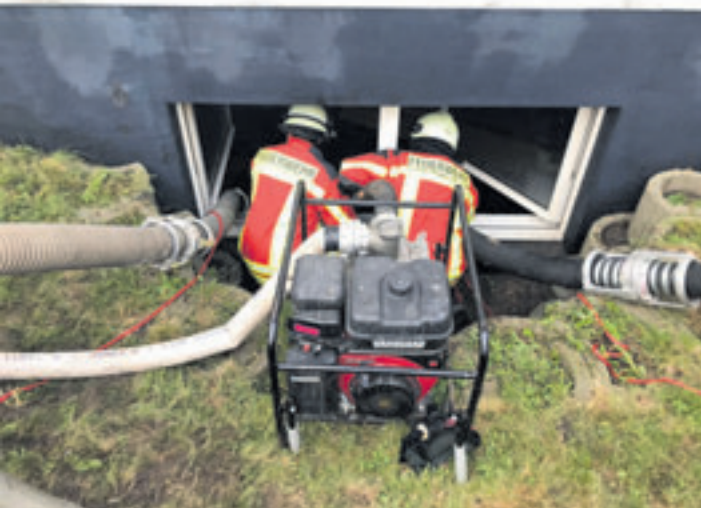
Die Feuerwehren mussten am 18. Juni rund 60 Mal zum Auspumpen von Kellern ausrücken Foto: Finn Griehl
