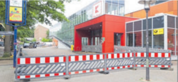
Die Baustelle wird weiträumig abgesperrt
