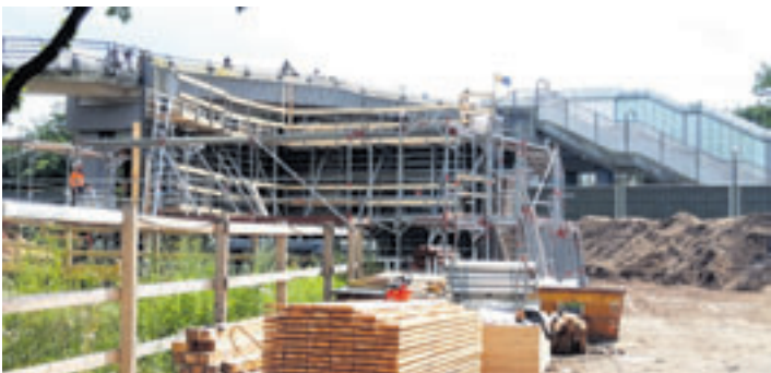
Auch die Rampenanlage soll später für einen weiteren Wohnturm demon- tiert werden Fotos: W. Marsand
