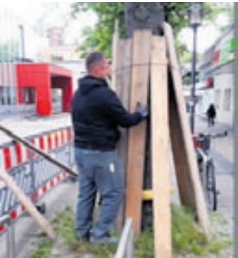
Bäume werden mit einem Stammschutz aus Holzbrettern versehen
