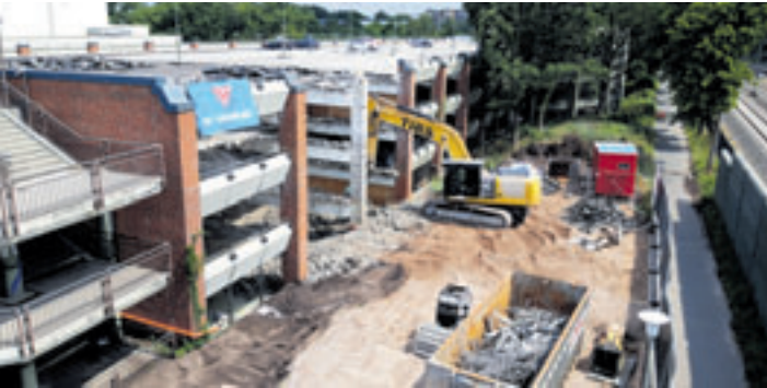
Ein mächtiger Bagger reißt Lücken in das Parkhaus
