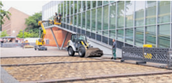
Die alte Pflasterung wird entfernt
