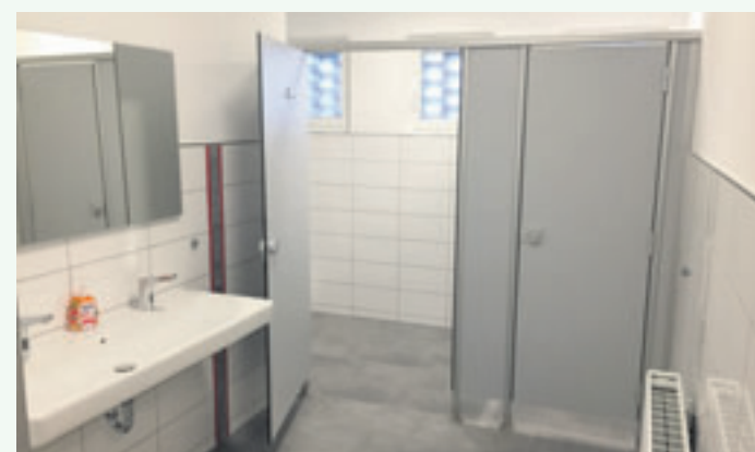
Die Sanierung der sanitären Anlagen wurde bereits 2019 abgeschlossen Foto: mk
