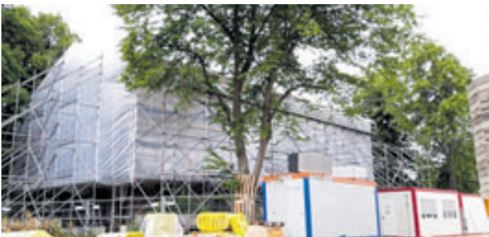
Die alte Fischbeker Schulkate soll wiederaufgebaut und Standort der Geschichtswerkstatt Süderelbe-Archiv werden Foto: W. Marsand
