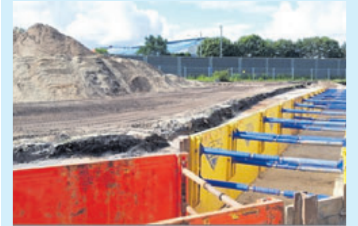
Laut IBA handelt es sich bei dem Schacht um die Baugrube für erforderliche Leitungsumlegungen der Wasserver- und -entsorgung
