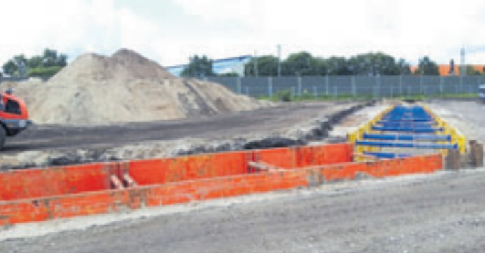
Die neuen Leitungen von Hamburg Wasser sind nötig, damit der neue S-Bahnzugang (Tunnel) umgesetzt werden kann Foto: W. Marsand
