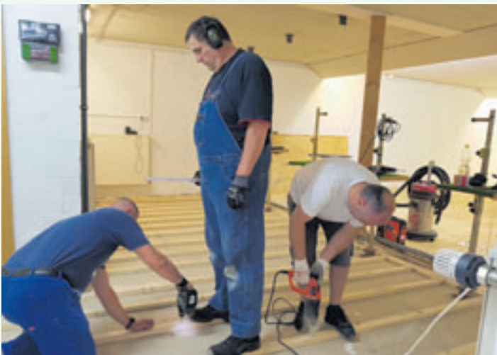
Die Sanierung des Luftgewehr-Standes schreitet zügig voran
