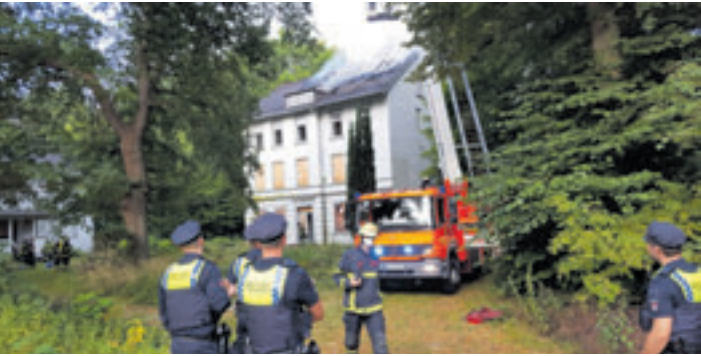
Der „Alte Jägerhof“ wurde durch das Feuer am 9. August stark beschädigt.
