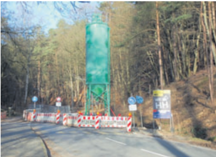
Zum Verfüllen der Bergwerksstollen wurde extra ein Silo installiert Foto: mk
