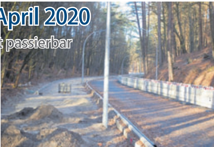
Die für Fußgänger, Radfahrer und Autofahrer neu angelegten Spuren sind weit fortgeschritten Foto: mk
