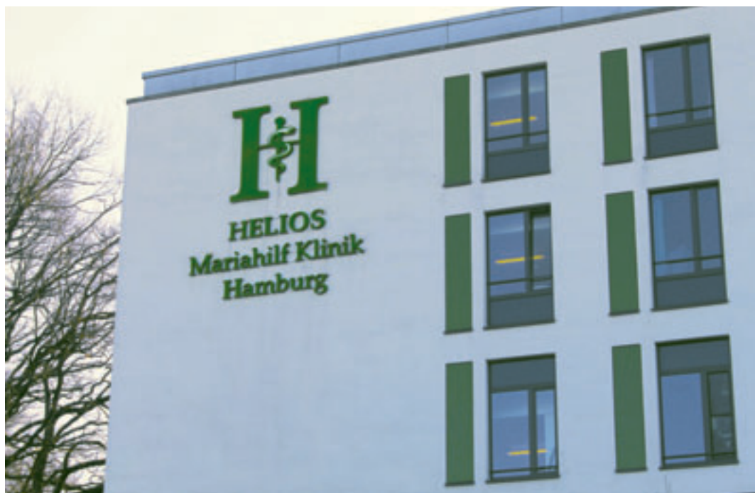
Das Krankenhaus kündigte an, das Haus noch im März einer erneuten Prüfung zu unterziehen Foto: pm
