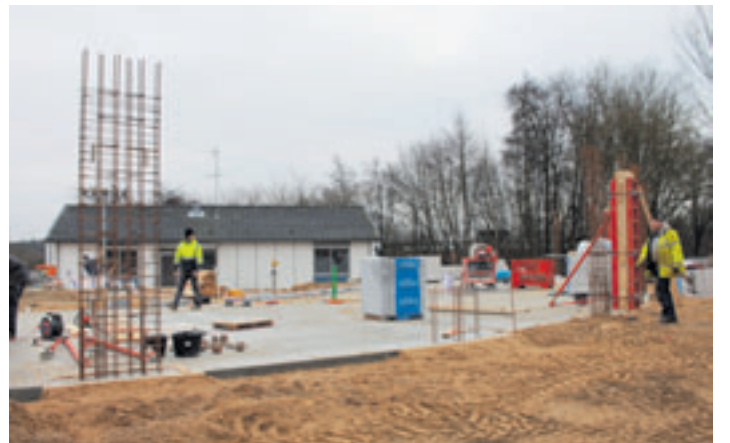
Die Baustelle „Königsberger Straße“ mit dem translozierten Quelle-Fertighaus im Hintergrund
