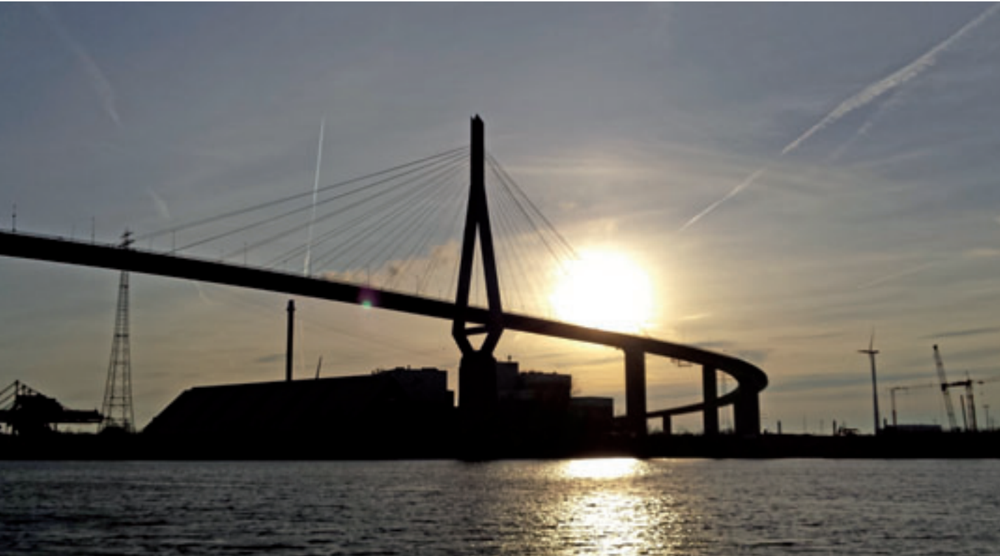
Die Köhlbrandbrücke ist eine der wichtigsten Verkehrsachsen über die Süderelbe. Prognosen gehen davon aus, dass die Brücke 2030 das Ende ihrer Lebensdauer erreicht. Foto: au
