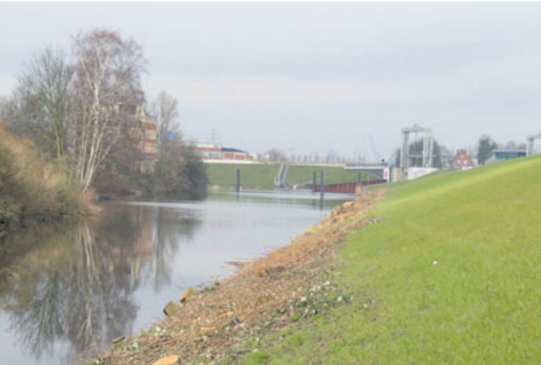
Auf rund 400 Metern wurden am Deichfuß des Klütjenfelder Hauptdeichs die Bäume gefällt. Der Grund: die Wiederherstellung der Deichsicherheit.
