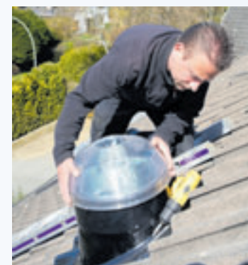
Dachdeckermeister Christian Wiese beim Einbau einer Solatube.
