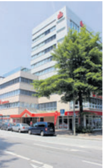
Die Sparkasse Harburg-Buxtehude in Harburg am Sand Foto: Sparkasse Harb.-Bux.
