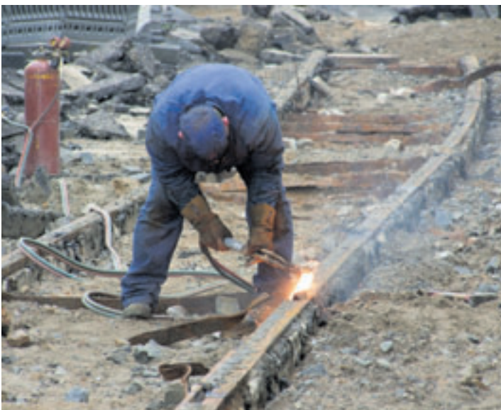
Jetzt geht es den Schienen an den Kragen Fotos: Siegfried Allerding
