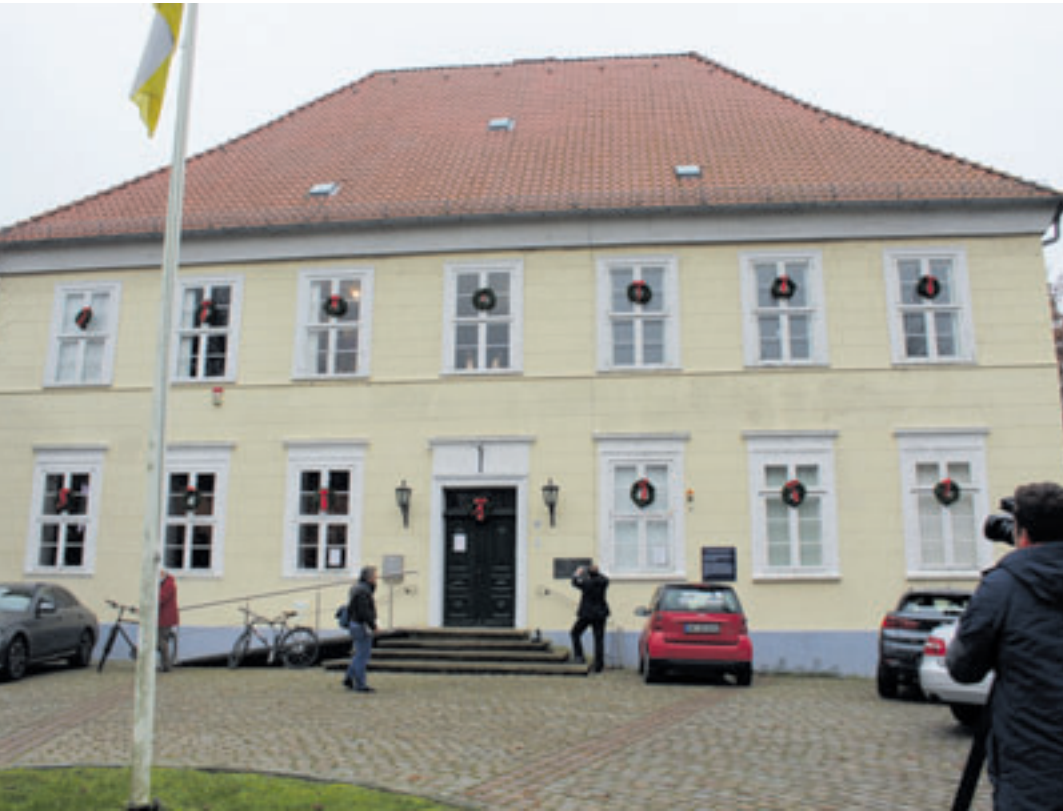
Das Museum Elbinsel Wilhelmsburg soll für rund zehn Millionen Euro grundsaniert werden. Unter anderem ist ein Fahrstuhl an der Außenfassad geplant, damit das Museum barrierefrei wird. Foto: au
