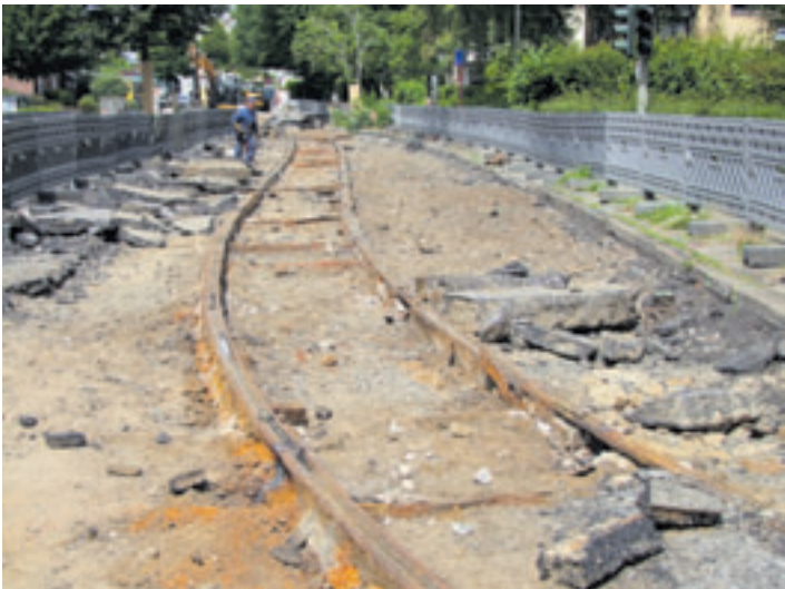
Die Schienen der Straßenbahn an der Endhaltestelle in Rönneburg
