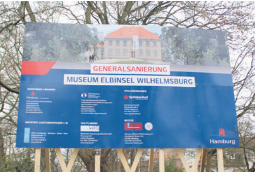
Außer dem Aufstellen des Bauschilds ist im Museum Elbinsel Wilhelmsburg bisher nicht viel passiert. Die Sanierung wird sich um einiges verzögern.
