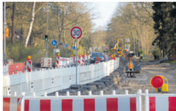
Die für die Sommerferien angekündigte Vollsperrung des Ehestorfer Heuwegs wird nicht erfolgen Foto: mk
