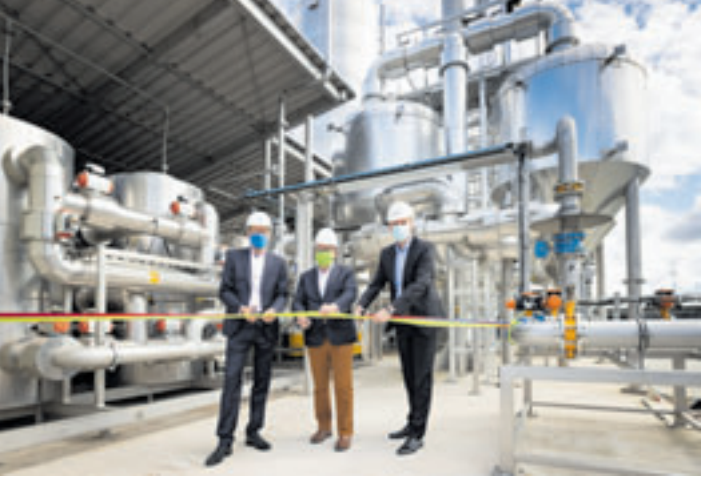
Die Geschäftsführer Ingo Hannemann (links, Hamburg Wasser), Udo Bottlaender (Mitte, Gasnetz Hamburg) und Michael Prinz (Hamburg Energie) bei der symbolischen Inbetriebnahme der neuen Gasaufbereitungsanlage GALA2 Foto: Hamburg Wasser
