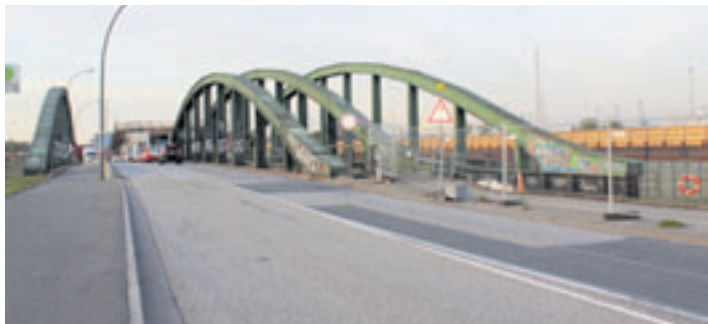
Für Bauarbeiten an der Veddelkanalbrücke wird der Verkehrsknotenpunkt Neuhöfer Straße/Reiherstieg-Hauptdeich optimiert Foto: au
