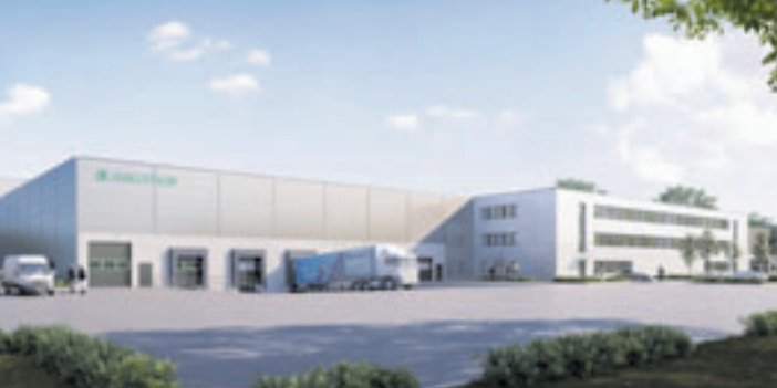
Ansicht des neuen Zentrallagers der Asklepios Kliniken in Bad Oldesloe Asklepios Kliniken GmbH & Co. KGaA, Fotograf: Daniel C. Wolf (Formfest)
