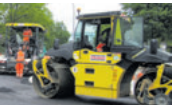
Ab dem 24. August werden einige Kreisstraßen instandgesetzt
