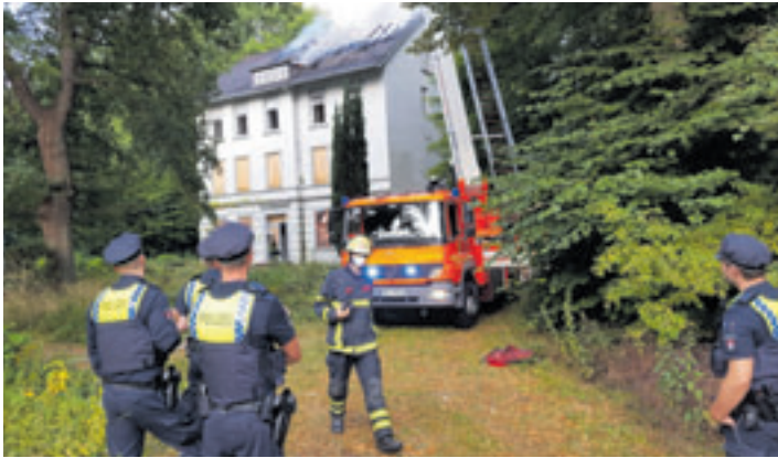
Der „Alte Jägerhof“ wurde durch das Feuer am 9. August stark beschädigt. Foto: HHF
