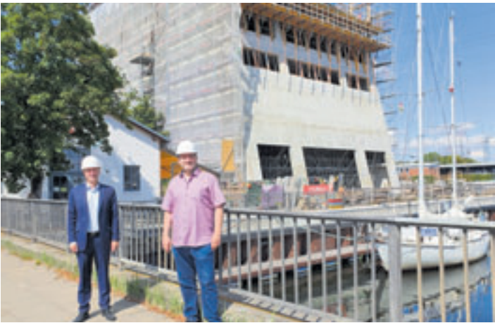
Prof. Dr. Carlos Jahn und Metin Hakverdi vor dem im Bau befindlichen Fraunhofer-Center Foto: SPD
