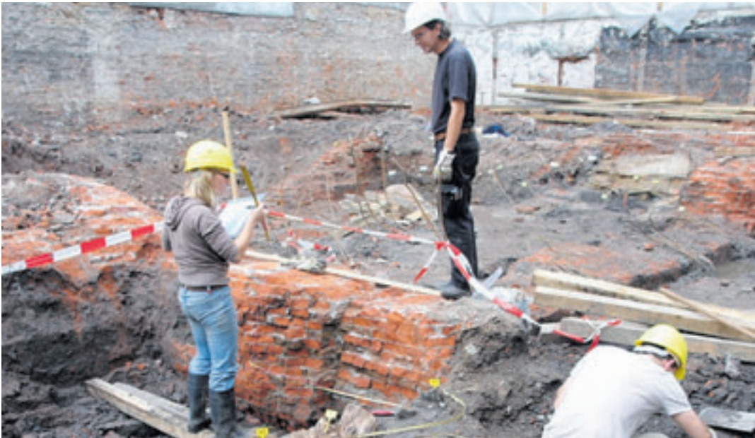
Auf der Ausgrabung 2006: Erstmals seit dem Großen Brand 1842 tauchen wieder die Fundamente der Nikolaikirche auf Foto: Arch. Mus. Hamb.
