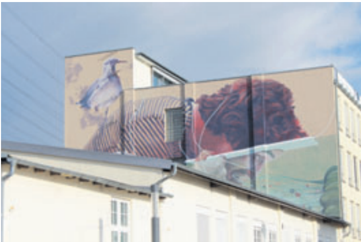
Blickfang am Lotsekei: Innerfields sorgte beim WCD für den Durchblick mit Tiefgang Foto: pm
