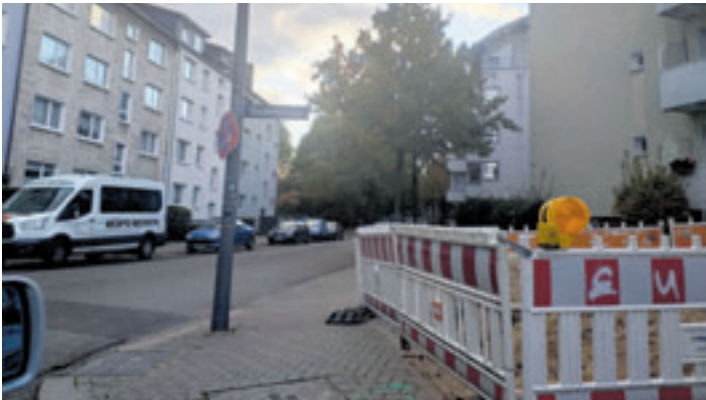
In der Kreuzung Denickestraße/Gazertstraße stehen bereits die Vorboten der Baustelle Foto: pm
