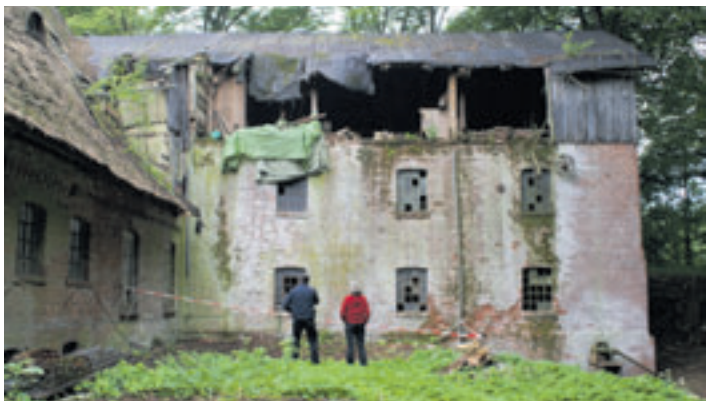
Zimmerermeister Andreas Brauel und Emily Weede vor vier Jahren vor der Mühle, damals noch in desolatem Zustand
