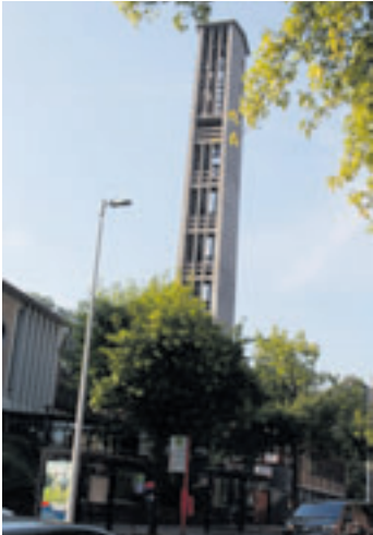
Eine knappe Million für die Sanierung des St. Johannis-Kirchturmes Foto: pm
