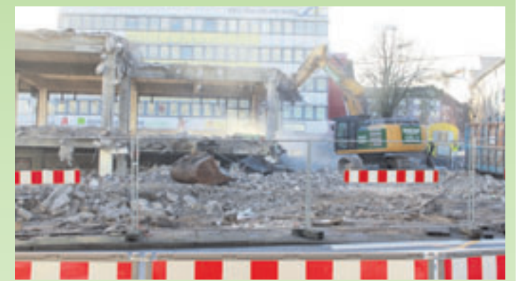
Der Abrissbagger leistet ganze Arbeit
