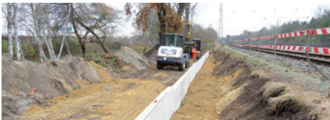
Ein weiteres Stück der Veloroute 10 wird gerade fertiggestellt
