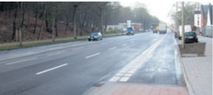
In diesem Abschnitt der Veloroute 10 von der Hamburger City nach Neugraben wurden weitgehend die Standardbreiten für Radschnellwege von 2 m umgesetzt Foto: W. Marsand
