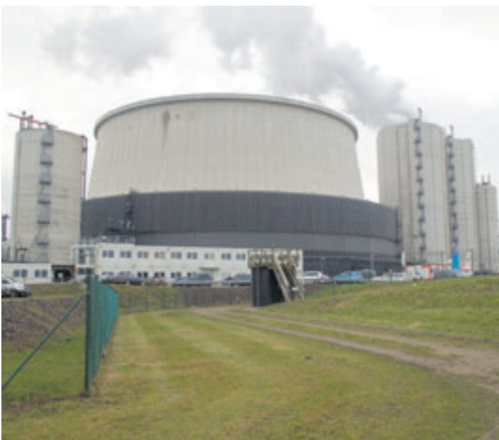
Das erst 2015 in Betrieb gegangene Kohlekraftwerk Moorburg soll bereits 2021 wieder abgeschaltet werden Fotos: mk
