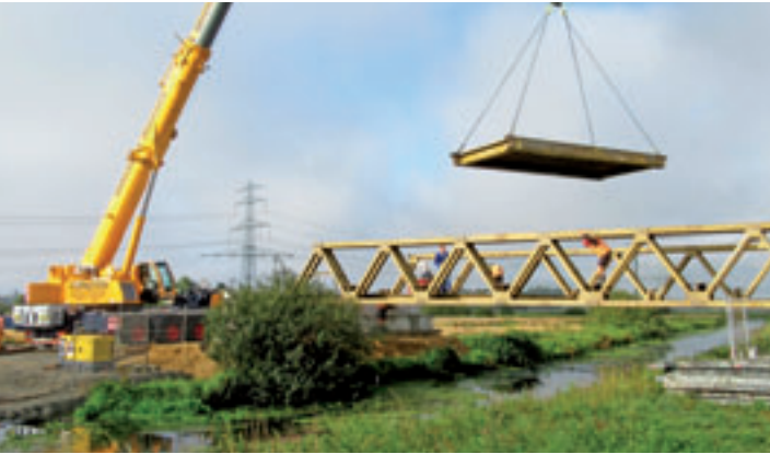
Über die Landschaft wurde eine Behelfsbrücke installiert Foto: Marsand
