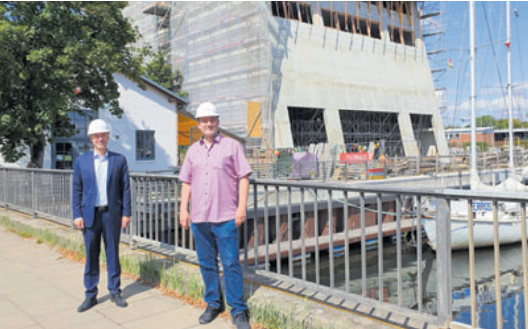
Prof. Dr. Carlos Jahn und Metin Hakverdi vor dem im Bau befindlichen Fraunhofer-Center Foto: SPD
