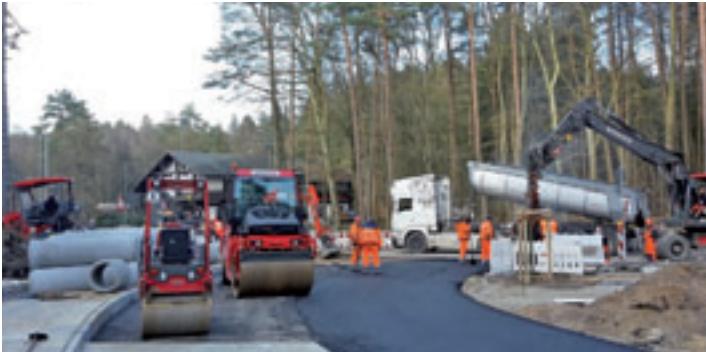
Die Bauarbeiten am Ehestorfer Heuweg gestalten sich schwierig Foto: M. Achner
