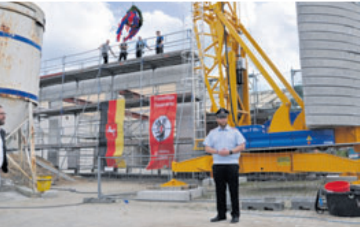
Der stellvertretende Ortsbrandmeister von Rübke, Nikolaj Stender, hielt zum Richtfest eine Rede. Foto: Finn Griehl
