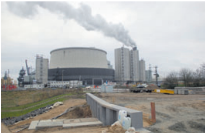
Die dem Betreiber des Kraftwerks Moorburg von Hamburg erteilte Erlaubnis zur Entnahme und zum Wiedereinleiten von Elbwasser zum Zweck der sog. Durchlaufkühlung ist laut Urteil des Oberverwaltungsgerichtes Hamburg rechtswidrig und nicht vollziehbar Foto: mk
