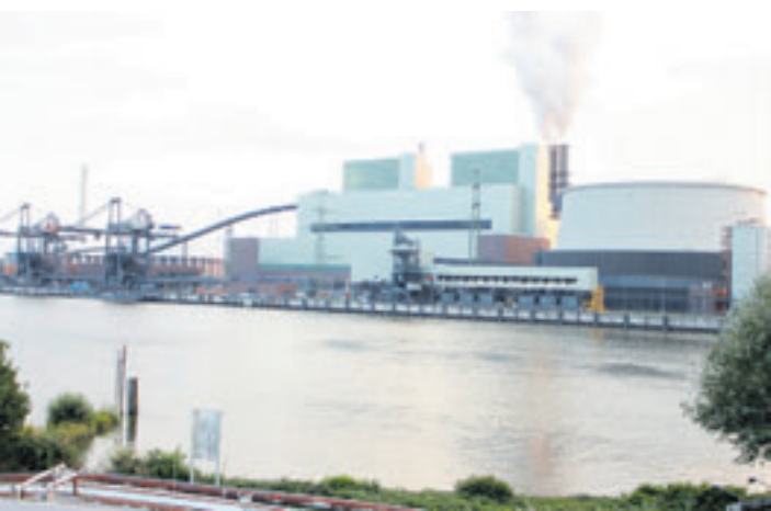
Wird das Kohlekraftwerk Moorburg des schwedischen Konzerns Vattenfall, das erst seit fünf Jahren am Netz ist, nächstes Jahr schon wieder stillgelegt? Foto: pm
