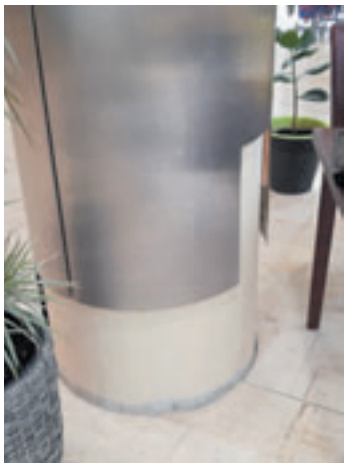
Im Eis-Café Veneto ragen Blechverkleidungen mit scharfen Kanten hervor. Foto: c. steinert
