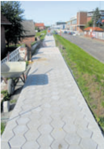
Der Deichkronenweg im Bereich des Neuenfelder Fährdeiches wird zurzeit modernisiert
