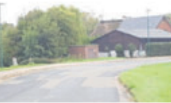
In der Buxtehuder Straße wurden neue energiesparende LED-Leuchten montiert Foto: Gemeinde Neu Wulmstorf
