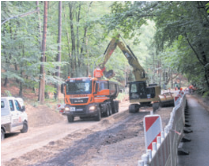
Im Laufe der Jahre jagte eine Panne die nächste auf der Baustelle des Ehestorfer Heuweges Foto: W. Marsand
